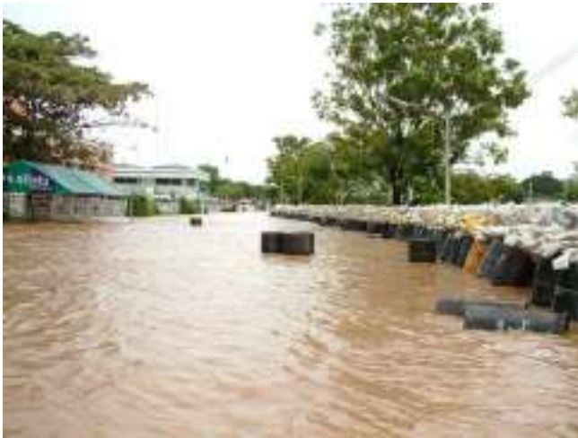
เสริมคันกันน้ำด้วยกระสอบทราย
