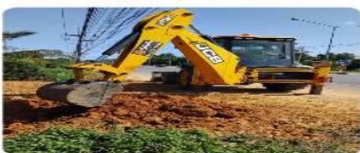
กองช่างดำเนินการขุดลอกร่องระบายน้ำ หมู่ที่ 6
